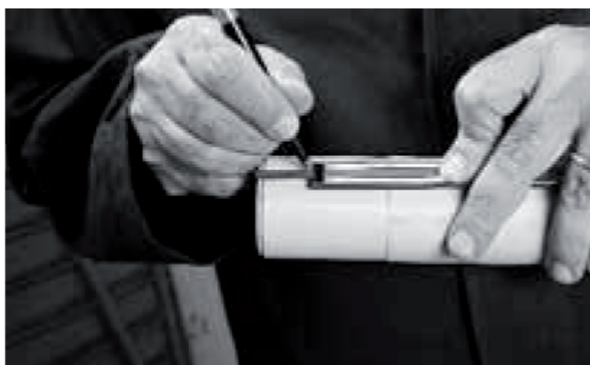
Obr.č.5: Na rúrach dĺžku nasunutia L_1 (tab.č.2.) treba označiť a skontrolovať, či daná dĺžka nasunutia je vhodná pre kvalitné vykonanie zvárania.
