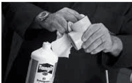
Obr.č.6: Zvarované plochy treba dôkladne očistiť, aby z povrchu rúr a tvaroviek boli odstránené mastnoty a iné nečistoty.
