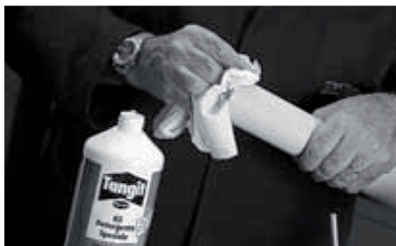
Obr.č.6: Zvarované plochy treba dôkladne očistiť, aby z povrchu rúr a tvaroviek boli odstránené mastnoty a iné nečistoty.
