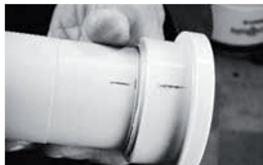
Obr.č.8: Po uplynutí doby nahrievania rúru a tvarovku z nahrievacieho telesa treba rýchlo odstrániť a treba ich rýchlo vsunúť do seba až po značku. Treba sa vyvarovať vzájomného pootáčania sa súčiastok!
